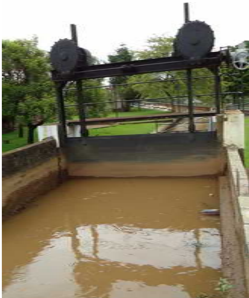
Comporta por onde a água entra no aqueduto – vista frontal, por fora da área de visitação.
