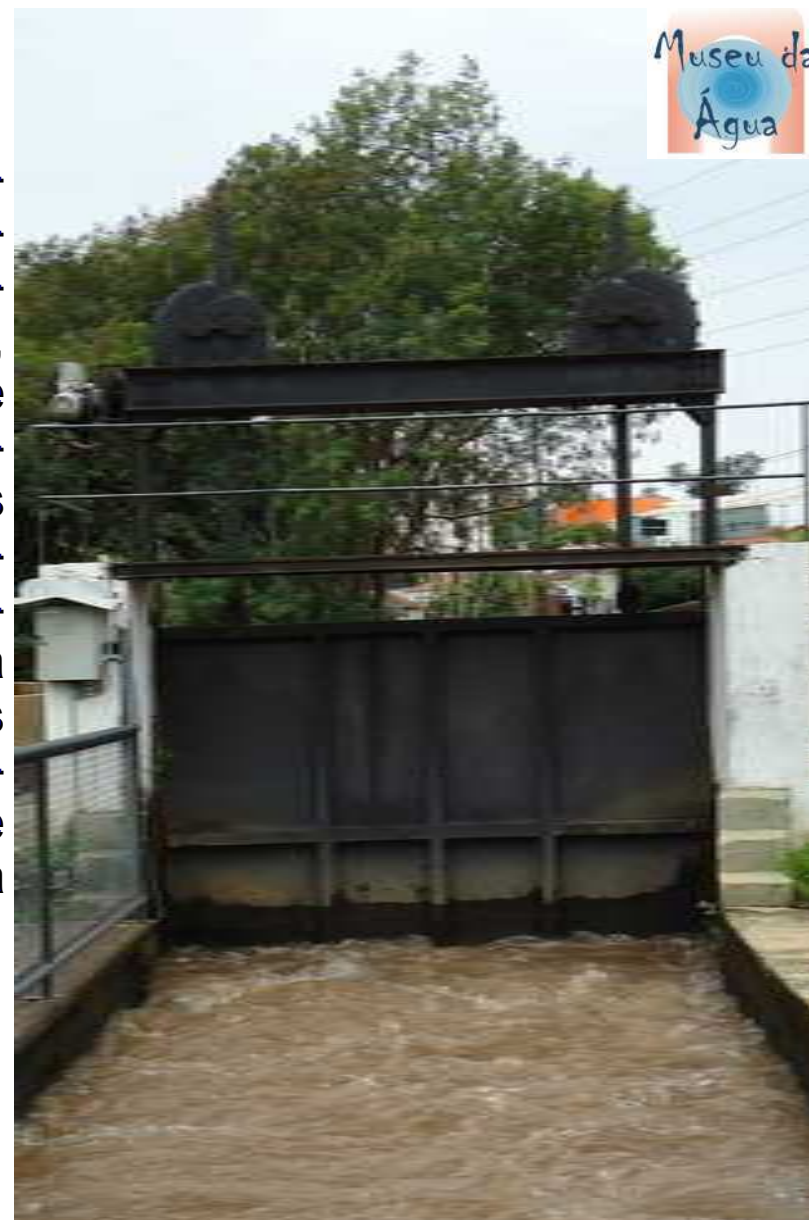
Vista traseira da mesma comporta – também por fora da área de visitação.
