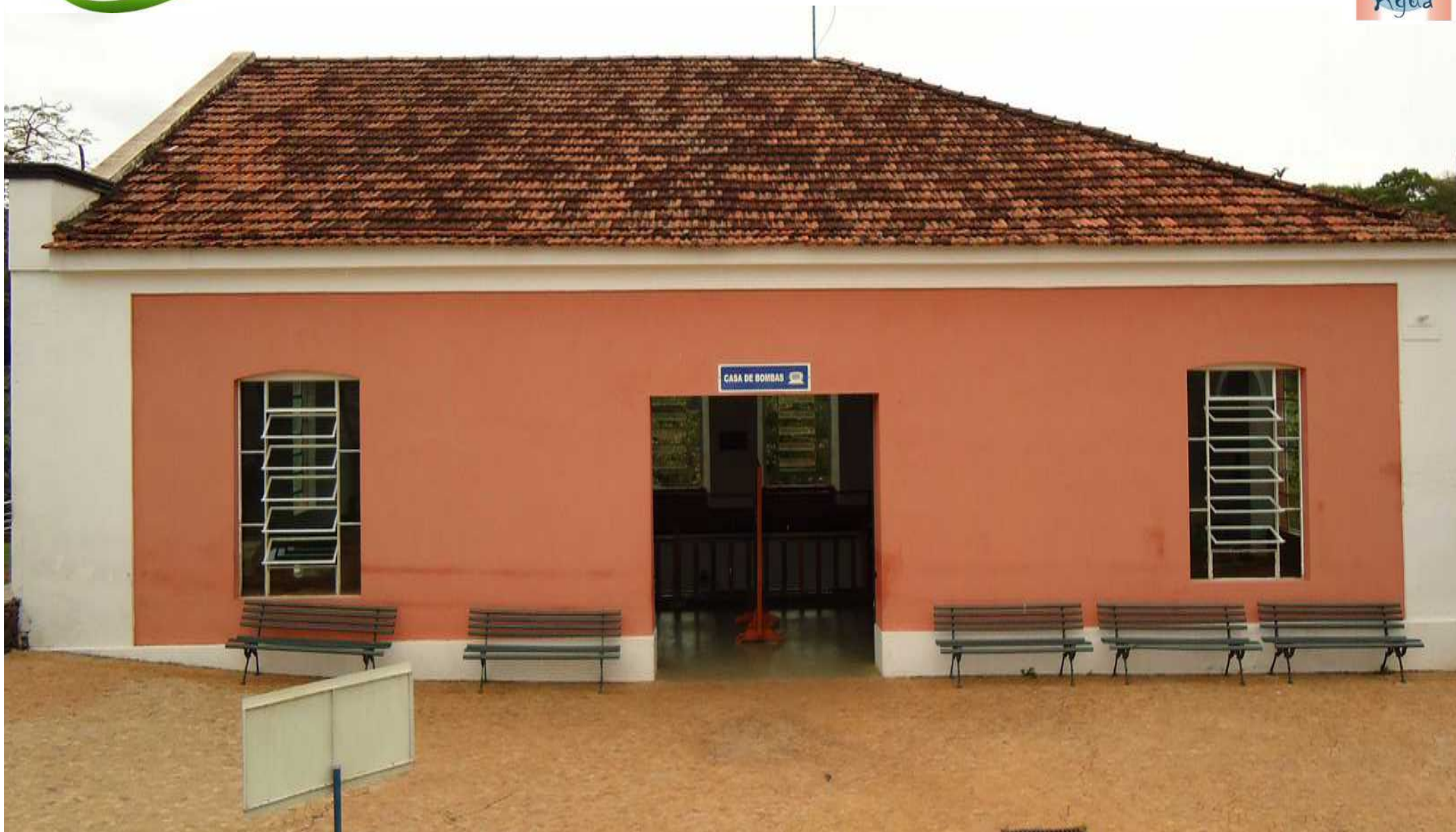
Vista parcial frontal da Casa de Bombas
