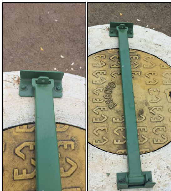
Figuras 13 e 14: Modelo da trava na tampa.
