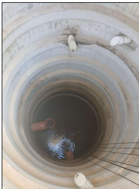
Figura 06: Poço de sucção.
