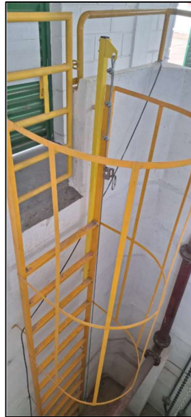
Figura 22: Modelo da escada marinheiro com a linha de vida.
