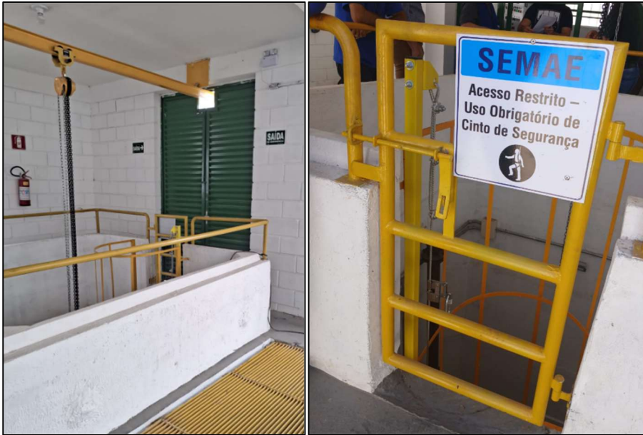
Figuras 20 e 21: Guarda-Corpo de portão para acesso controlado.
