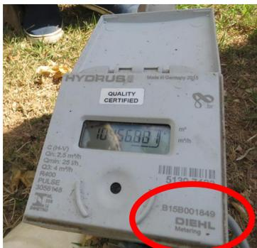
Fig. 05 . hidrômetro ultrassônico
