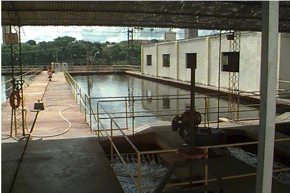
Fotografia 6 - Vista de um dos flocculadores e decantadores da ETA II
