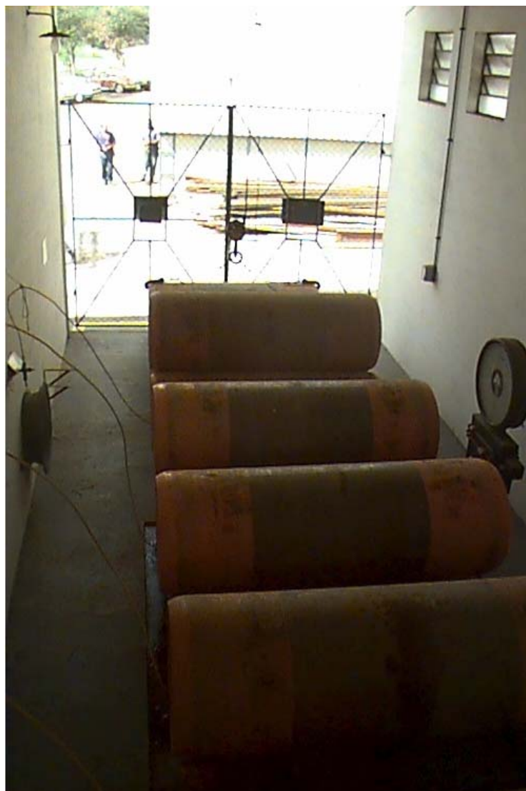
Fotografia 8 - Depósito de cilindros de cloro (900 kg) das ETAs I e II 1
