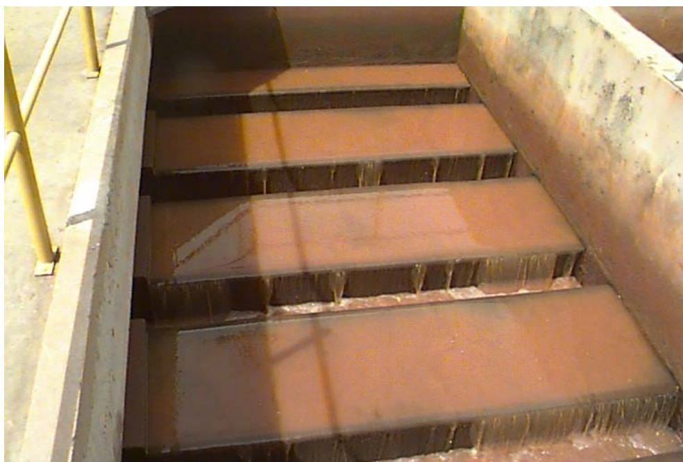
Fotografia 11 - Detalhe de um filtro durante processo de retrolavagem
