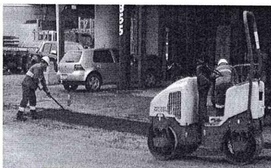
O rolo compactador deverá ser transportado por reboque em conjunto ao caminhão basculante da massa asfáltica, e caso haja problemas com o equipamento o mesmo deverá ser substituído por outro em boas condições de uso.
