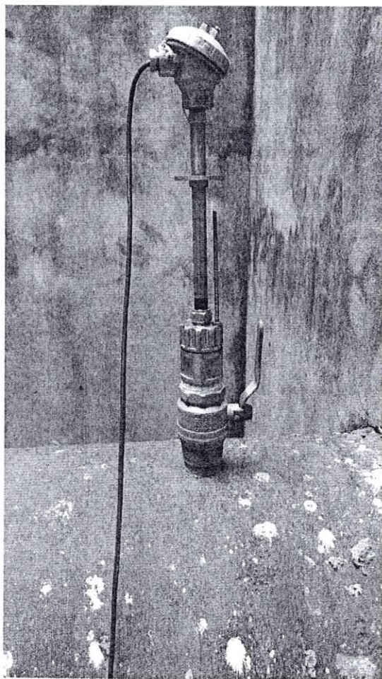
Foto 8: Detalhe do medidor de vazão de turbina instalado na Adutora de Água Bruta que envia água para as ETA'S 1 e 2.
