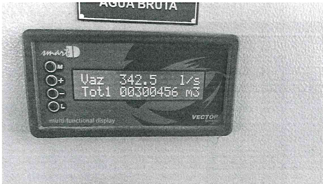
Foto 9: Painel totalizador e registrador de volumes domedidor de vazão de turbina instalado na Adutora de Água Bruta que envia água para as ETA'S 1 e 2 (Luiz de Queiroz).
